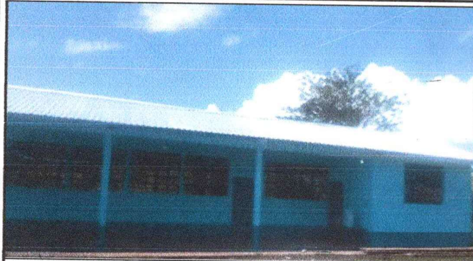
Foto1: SE REALIZÓ CAMBIO DE TECHO DEL ESTABLECIMIENTO.
