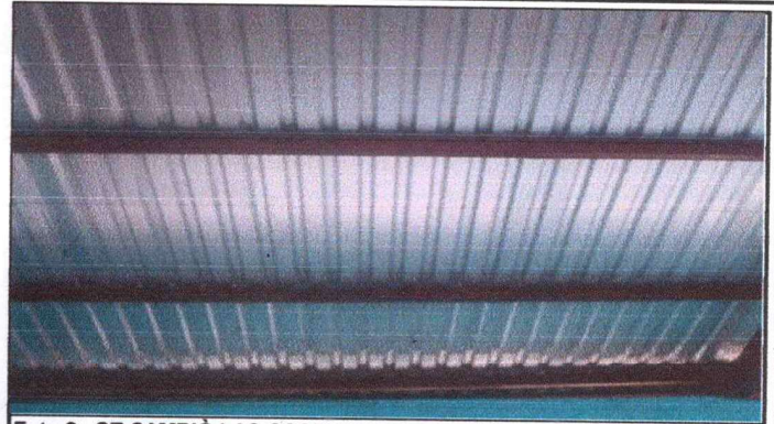
Foto 2: SE CAMBIÓ LAS COSTANERAS DE LAS AULAS.
